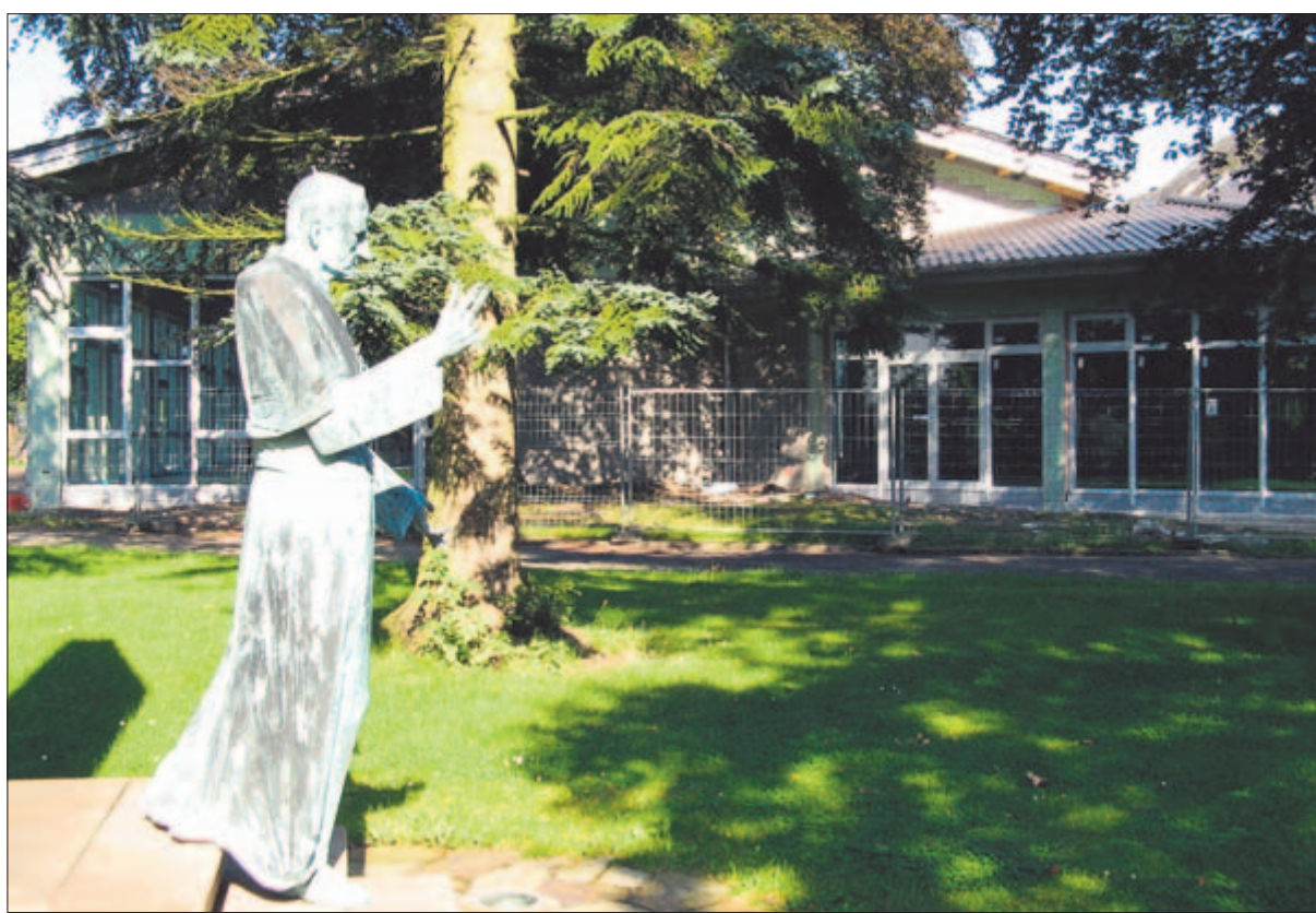
Ganz im Grünen, unmittelbar am Horhausener Kirchengarten, zu dem auch die beeindruckende Bronzeplastik Kardinal Höffners gehört, entsteht das neue Kaplan-Dasbach-Haus. Fotos (3): Petra Schmidt-Markoski
